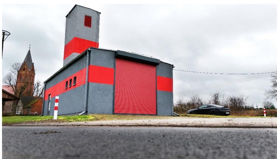
Zamontowana brama rolowana w budynku remizy OSP Góralice
