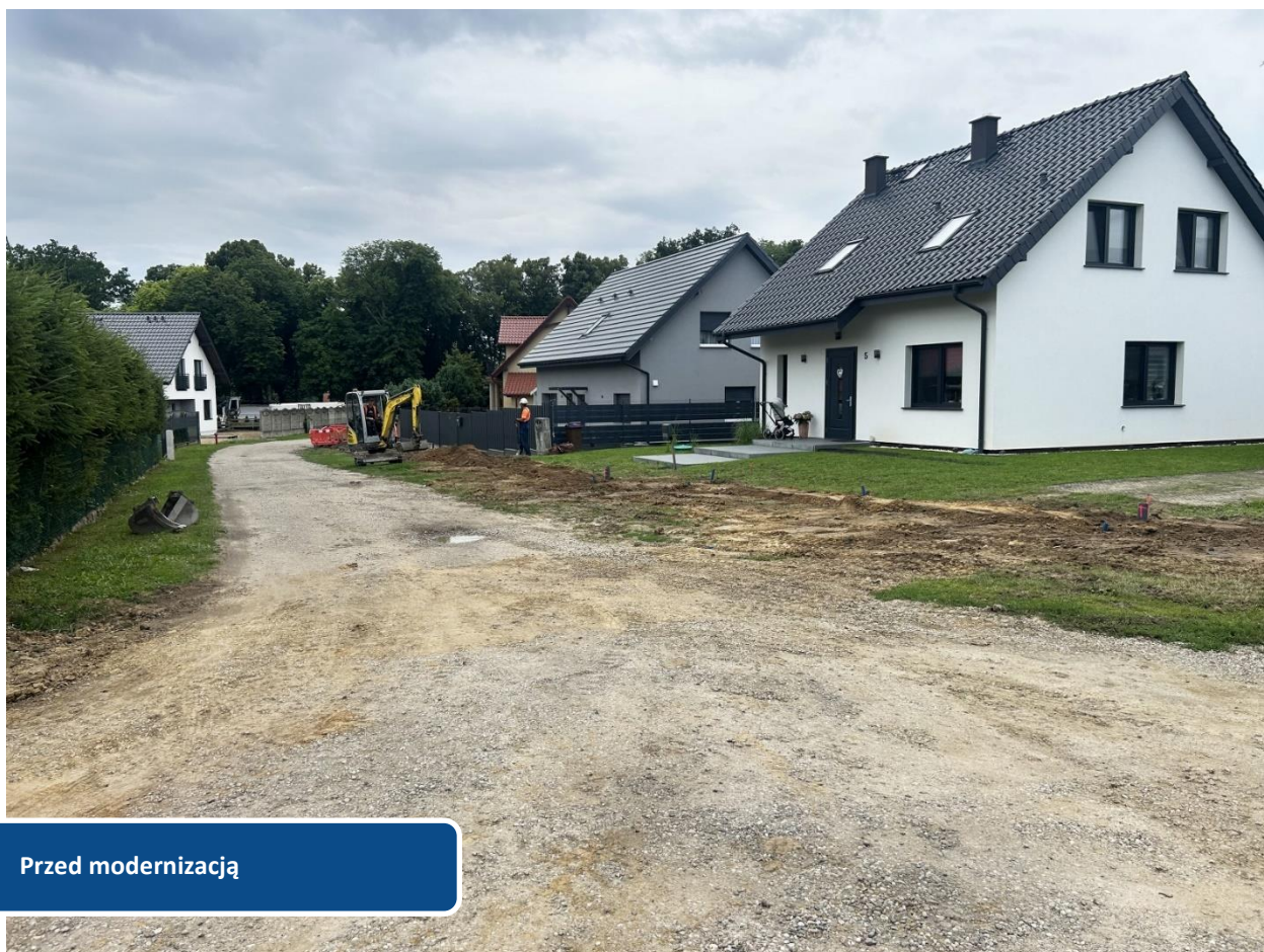
Budowa i modernizacja sieci dróg w Gminie Wartość zadania: 3 512 438,36 zł Dofinansowanie RPOZ Polski Ład: 2 665 950,67 zł Środki własne: 846 487,69 zł
